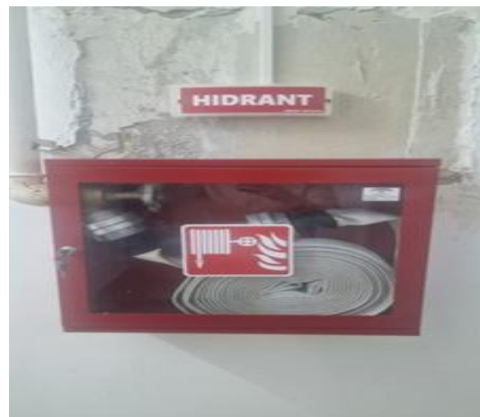
Fig. 16-casete hidranți
