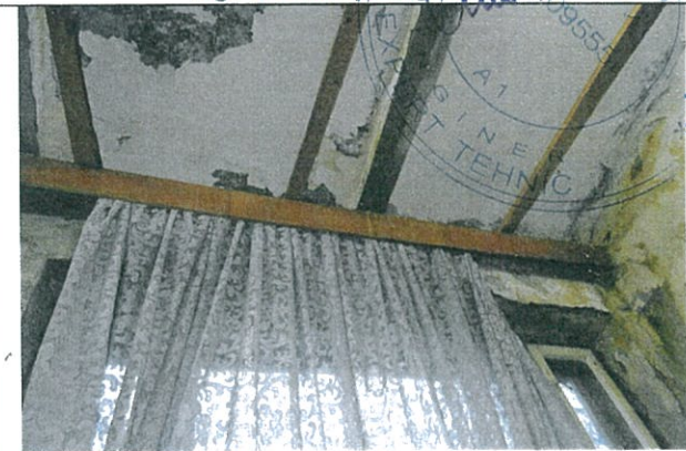
Fig. 22 Infiltrații acoperiș
