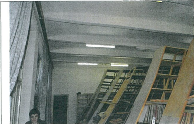
Fig. 17 Vedere interioară etaj
