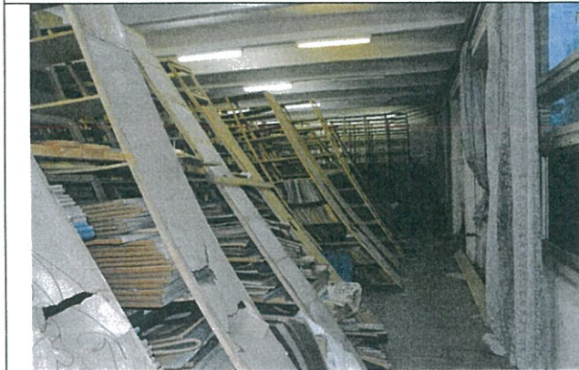
Fig. 19 Vedere interioară etaj
