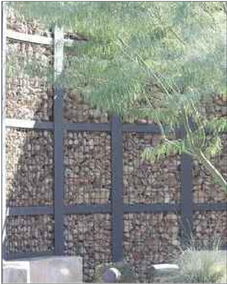
FOTO - MODELE DE GARDURI REALIZATE DIN GABIOANE DE PIATRA
