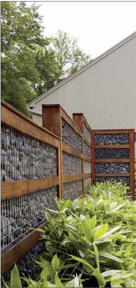
FOTO - MODELE DE GARDURI REALIZATE DIN GABIOANE DE PIATRA
