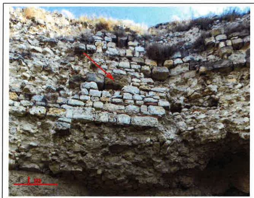
Fig. 8. Zidurile Cetatii Carsium. Imagini din corpul sudic si cel nordic, in care se observa moloane paralelipipedice de dimensiuni metrice.
