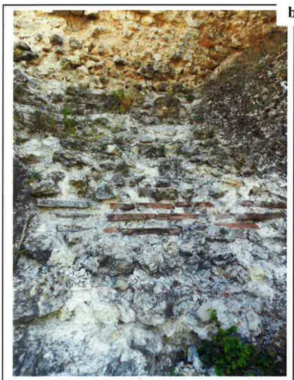
Fig. 20. Cetatea Carsium. Imagini de ansamblu (a) si de detaliu (b, c) ale zidului sudic (pe faleza Dunarii), cu precizarea zonelor din zidaria cu caramida integra (latera). In imaginea de detaliu 20.c, se observa si mortarul de var cu fragmente de caramida, dintre latere, cat si compatibilitatea extraordinar de buna a acestuia cu roca din fundamentul cetatii (calcarul oxfordian).
