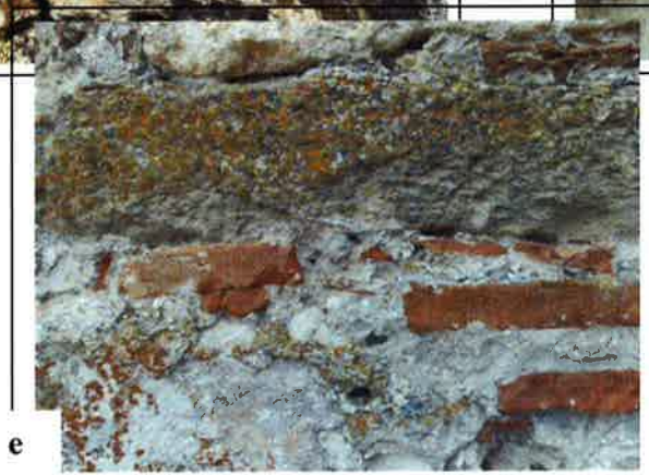
Fig. 21. Cetatea Carsium. Fragmente de caramida sau caramizi intregi utilizate ca blocuri in zidarie, alaturi de blocurile de piatra nefasonate. (a, b) zid S; (c) zid N; (d) zid W; (e) turn N.
