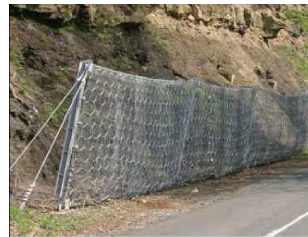
FOTO - MODELE DE GARD CU PLASA DE PROTECTIE SI CABLURI MATISATE
