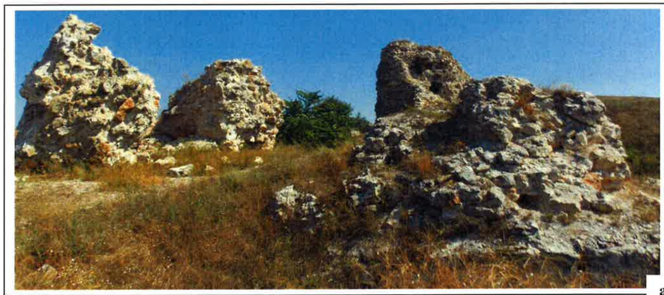
Fig. 13. Blocuri de piatra nefasonate din Cetatea Carsium: (a) Vedere de ansamblu, dinspre W, a zidurilor de pe latura de N si a turnului; (b) Turn, perete S: se observa o combinatie de blocuri fatetate, la exterior si nefatetate, ca umplutura; (c) Fragment din fatada sudica, spre faleza Dunarii: aceeasi combinatie de blocuri fatetate, la exterior si nefatetate, ca umplutura; (d) Detaliu din (c); (e) si (f) Imagini de ansamblu si de detaliu a zidariei de piatra, corp pe latura N.
