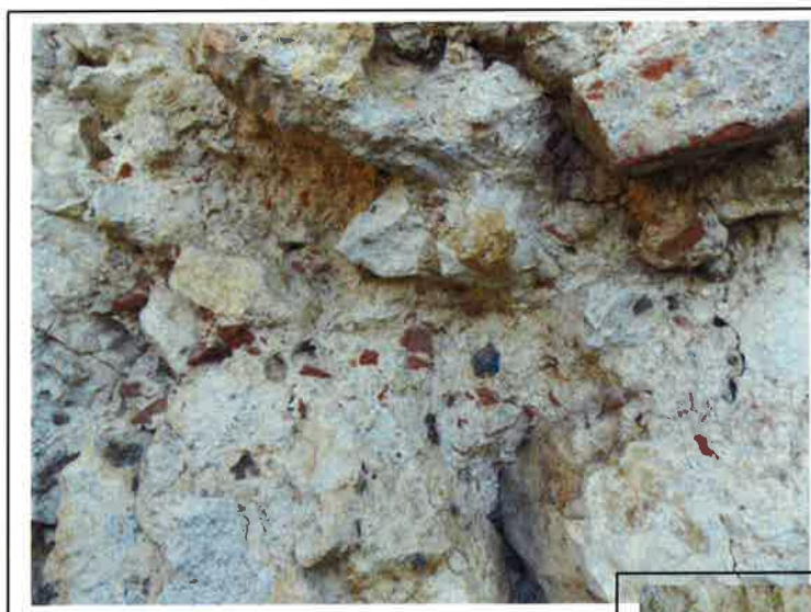
Fig. 19. Cetatea Carsium, zidul sudic. Se poate observa limita dintre cele doua generatii de zidarie, pe baza tipului de mortar: cel vechi, cu fragmente de caramida si cel mai nou, fara. (a) vedere de ansamblu; (b) limita dintre tipurile de zidarie; (c) mortar cu fragmente de caramida; (d) mortar fara aceste fragmente.
