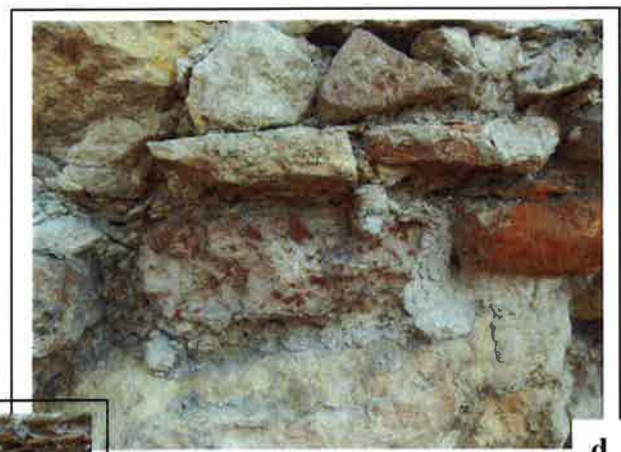
Fig. 21. Cetatea Carsium. Fragmente de caramida sau caramizi intregi utilizate ca blocuri in zidarie, alaturi de blocurile de piatra nefasonate. (a, b) zid S; (c) zid N; (d) zid W; (e) turn N.
