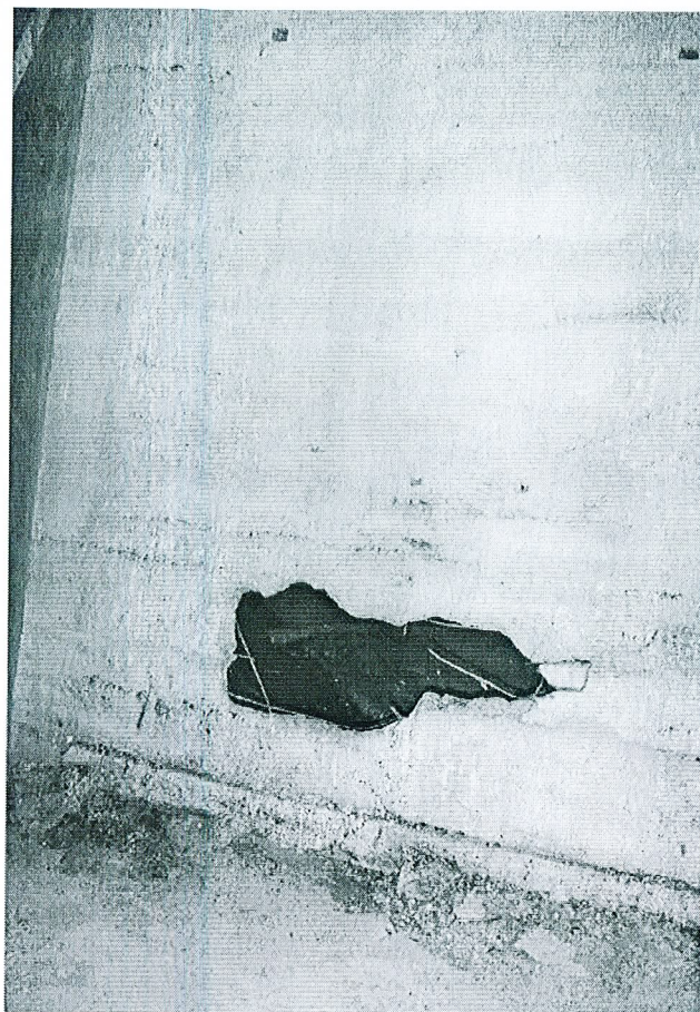
Baza turnului (interior)
