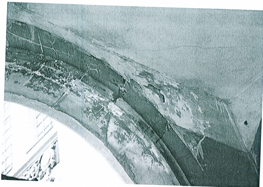
Portic latura de nord
