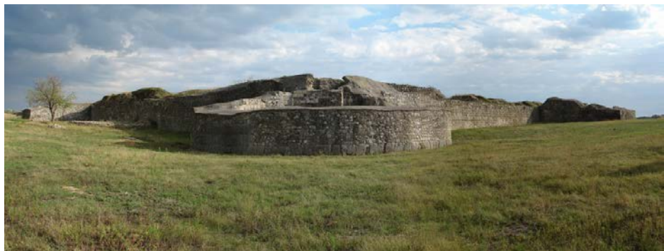
Zidul de incintă al Cetății Capidava
