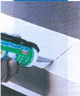
Etansarea flexibila a rosturilor de constructii
