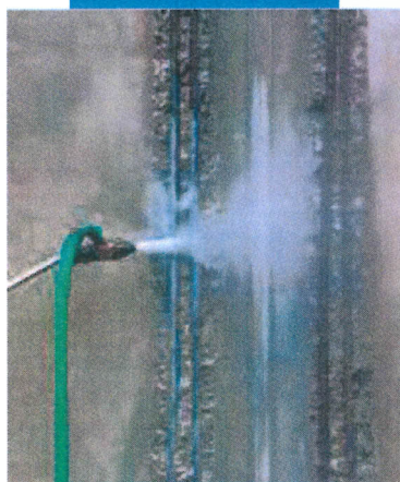
Curățarea barelor de armătură
