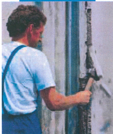
Îndepărtarea betonului degradat
