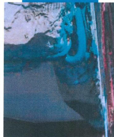
Bare de armătură de pe conturul unui balcon, protejate cu Mapefer 1K
