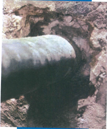
Demolarea structurii din jurul unei tevi
