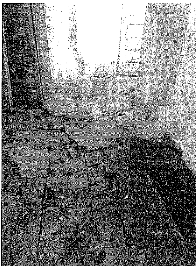
Trotuar perimetral colt lateral dreapta - spate
