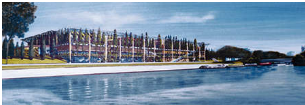
Fig 6.16 Instalația ISSEANE de valorificare energetică a deșeurilor municipale solide – incinerator de valorificare energetică în construcție într-un parc de lângă Paris. Instalația de 600 000 t/an va furniza, de asemenea, și încălzirea centrală pentru 90 000 de case și electricitate pentru 50 000 de case. Se estimează că stația va intra în funcțiune în anul 2007. Sursă SYMCOM, Regiunea Paris.
