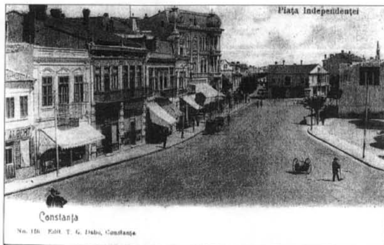
Foto 6. Vedere generală a Pieței Independenței (înainte de începerea lucrărilor)
