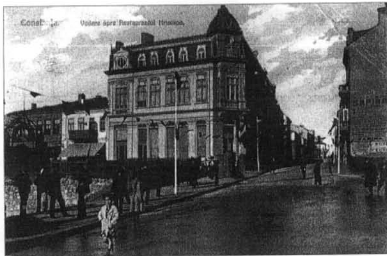
Foto 4. Vedere generală a Pieței Independenței (înainte de începerea lucrărilor)
