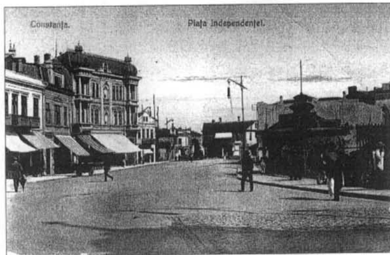
Foto 5. Vedere generală a Pieței Independenței (înainte de începerea lucrărilor)
