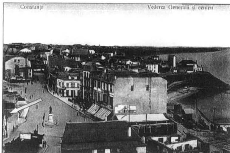
Foto 3. Vedere generală a Pieței Independenței (înainte de începerea lucrărilor)
