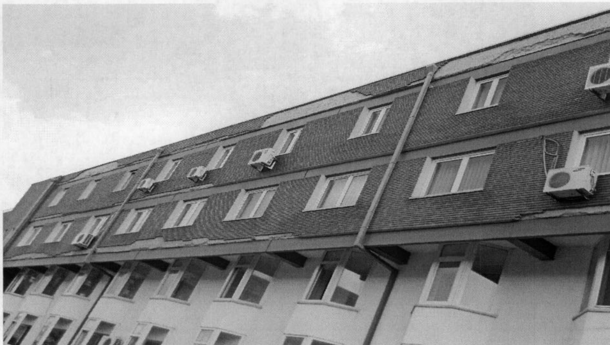
Figura 1- Latura de nord a clădirii - vedere generală
