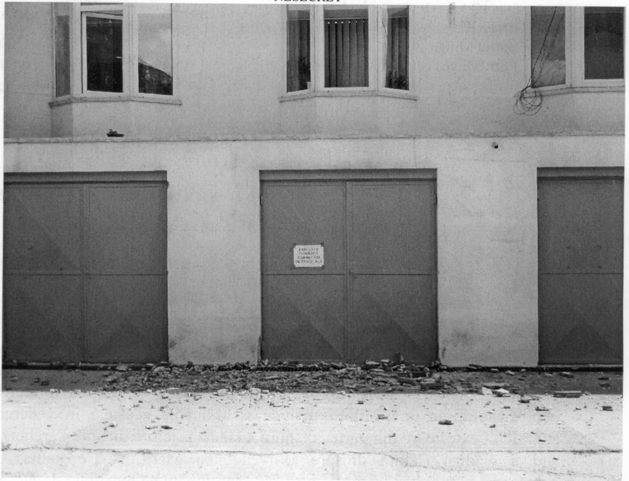
Figura - 2 Zonă unde a căzut tencuiala în luna august 2012
