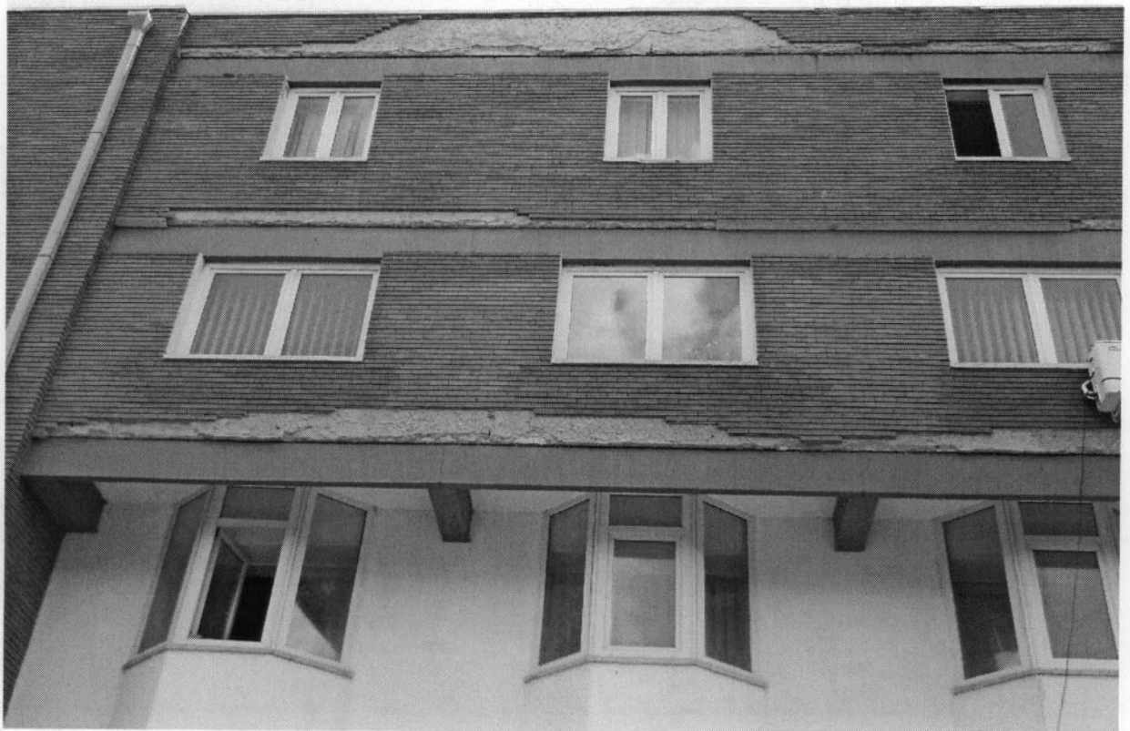
Figura 3 -Latura de nord a clădirii -zonă de unde a căzut tencuiala în luna august 2012
